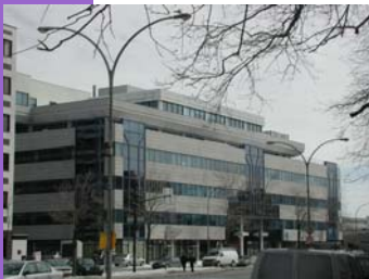
Pavillon 7077, avenue du Parc
