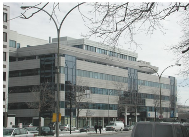
Pavillon 7077, avenue du Parc
